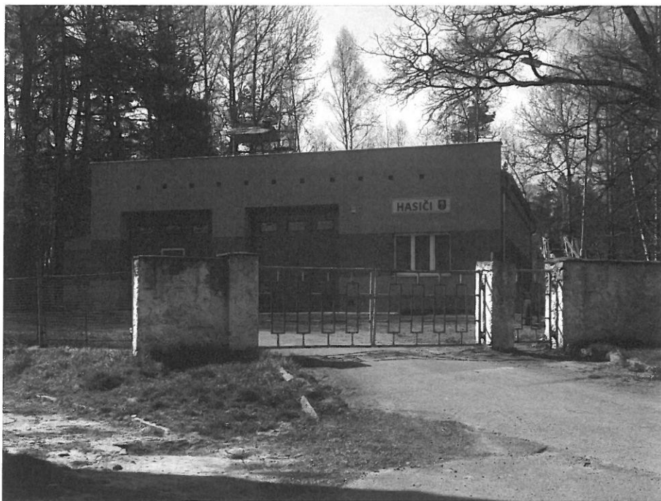
8 – opravená hasičská zbrojnice
