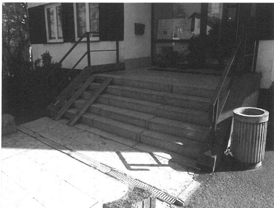
2 – Detail vstupu do objektu
